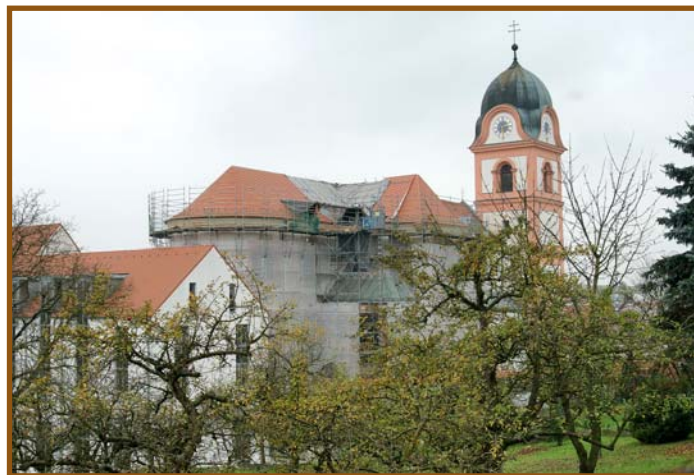
Seit März 2008 arbeitet Holzbau Semmler am Bauabschnitt I der Klosterkirche.
