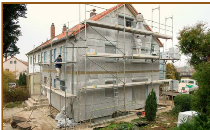
Die Doppelhaushälfte wird komplett saniert -vom Hemauer Handwerkerzentrum.
